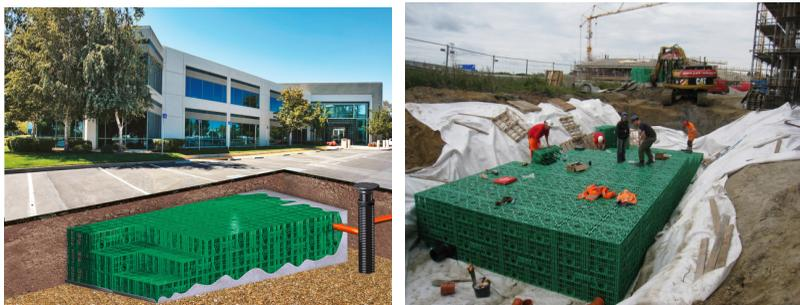
Рис. 10, 11. Система управления дождевыми стоками Raineo Stormbox
