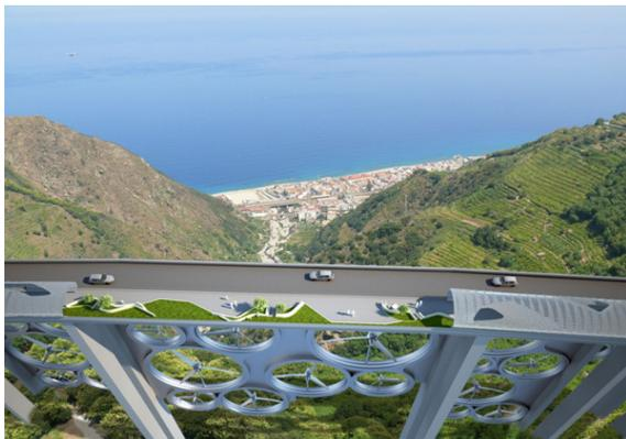
Рис. 3. Ветрогенераторы моста – виадукка [3]
