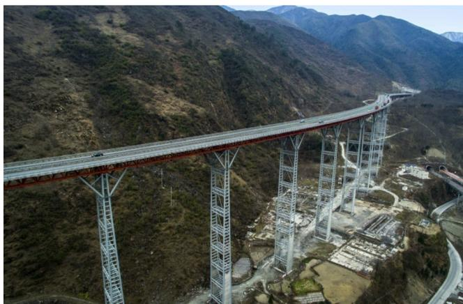
Рис. 2. Виадук со сквозными опорными конструкциями.
