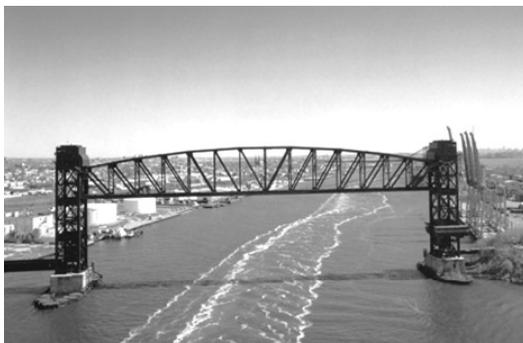
Рис. 3. Вертикальный подъемный мост Артура Килла [3]
